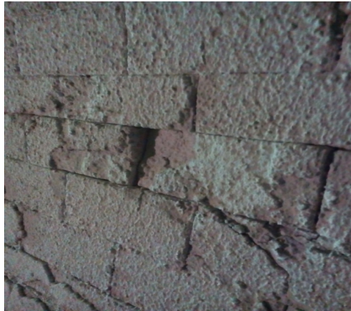
Рисунок 1 – Сколы огнеупоров в футеровке печи кальцинации
